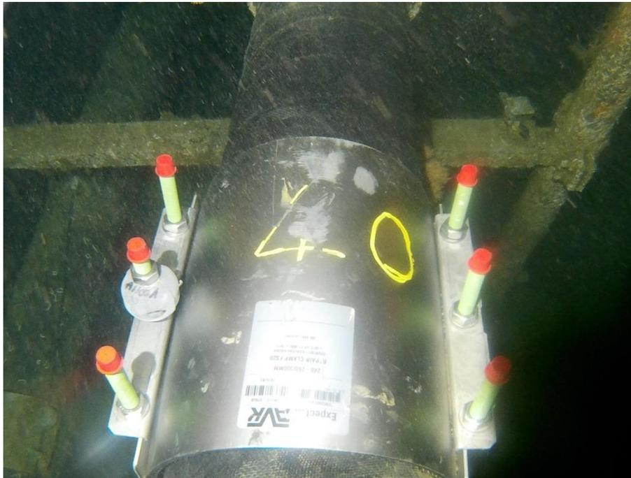
Remplacement des colliers pour contrôle d'épaisseur
